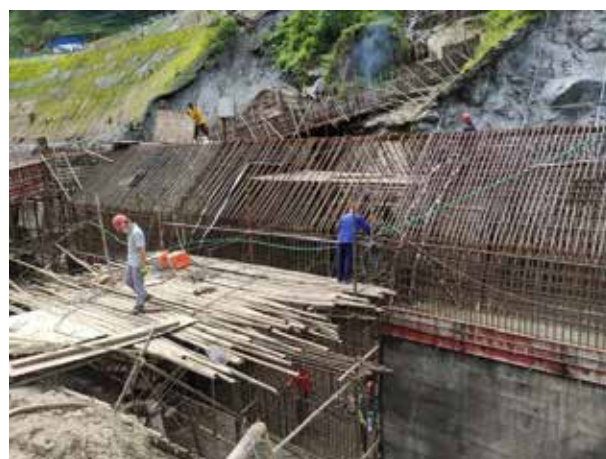
Pressure conduit construction
